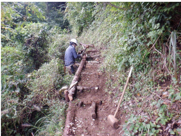
写真10 管理歩道の補修
