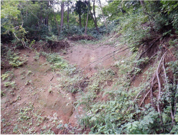
写真 20 崩壊地下部は崩壊範囲が広い
